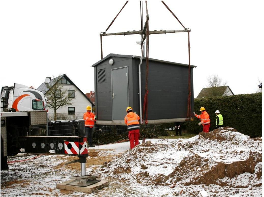
Nach dem Ende des Winters werden jetzt die umfangreichen Arbeiten zum Ausbau des Glasfasernetzes in den Straßen unserer Gemeinde ausgeführt. Im März konnte der „POP“ bzw. die zentrale Verteilerstation des Glasfasernetzes in der Ahornstraße aufgestellt werden. Von hier aus wird das Netz ausgebaut bzw. die weitere Verzweigung in den Straßen vorgenommen. In einigen Straßen wurden die Leerrohre ja bereits verlegt und das wird sich in den nächsten Wochen fortsetzen.
